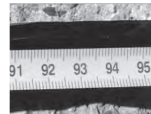
Obr. 8: Délka lepeného spoje pryže vyhovující
